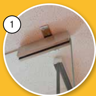
Detail bovenspeun Kozijndeel met scharnier
